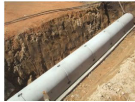
⑩施工完了
