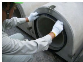
⑥ジョイントゴムの挿入
