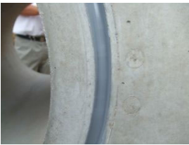
⑤接着剤の均しと充填確認
