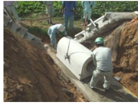
②製品据付け
