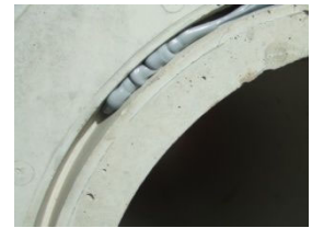
④充填は接合する両側の製品に行う
